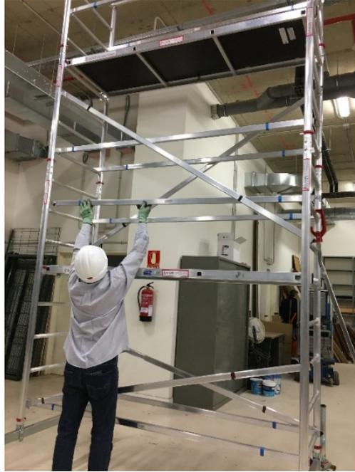
Bajar la plataforma del escalón del 7 al 5. Colocar el rodapié en la plataforma superior
