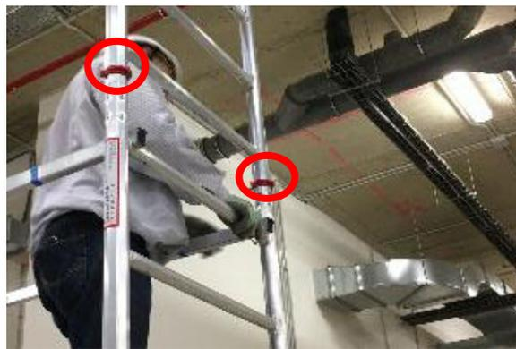
Colocar barras diagonales cruzadas (marcadas con cinta negra), entre el escalón 6 y el escalón 11. Recuerda las diagonales siempre van más externas que las barras horizontales.
