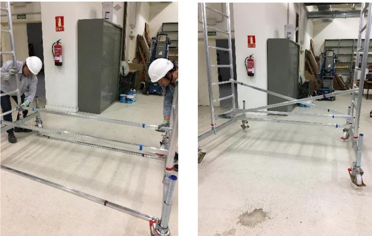
Colocar la plataforma en el 4º escalón y bajar los cuatro cierres de la plataforma. **Atención, asegurarse que la trampilla está sujeta antes de manipular la plataforma.**
