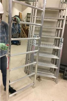
Acceder a la plataforma por la zona interior y colocar los dos marcos con sus cierres de seguridad.
