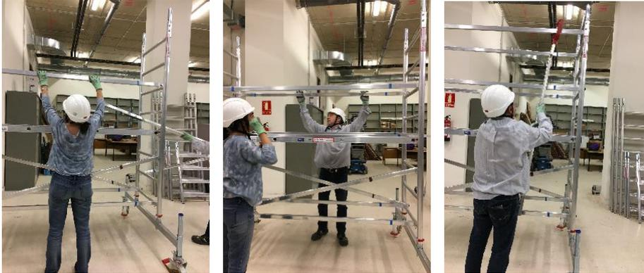
Tras montar el cuerpo se comprueba la nivelación del andamio en ambos ejes.
