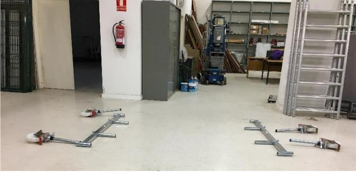
Colocar las ruedas, ajustando el tornillo al orificio existente para evitar la caída de las mismas y poniendo la pieza en el hueco superior para darle mayor rigidez. Se frenan las ruedas para continuar con el montaje.
