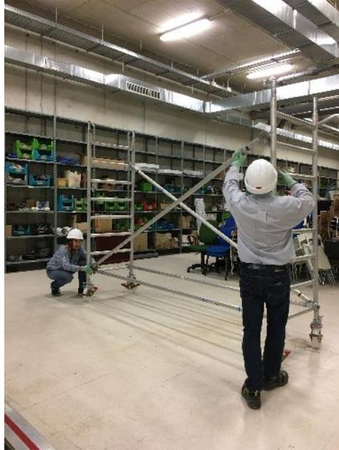
Tras montar el cuerpo comprobar la nivelación del andamio en ambos ejes.
