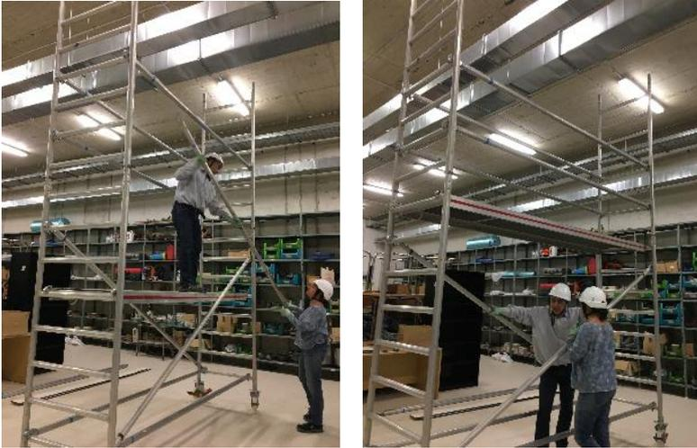
Montar el rodapié colocando primero las esquinas (piezas de plástico de color rojo) y luego los tableros.
