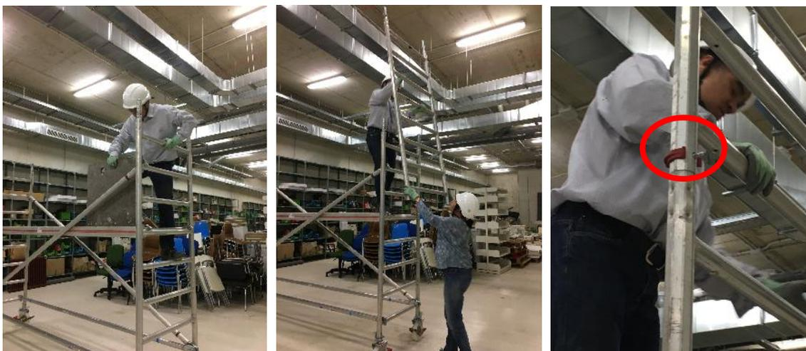
Se colocan barras horizontales (marcadas con cinta azul) para barandilla (escalón 11) y listón intermedio (escalón 9) y subimos plataforma al escalón 7.
