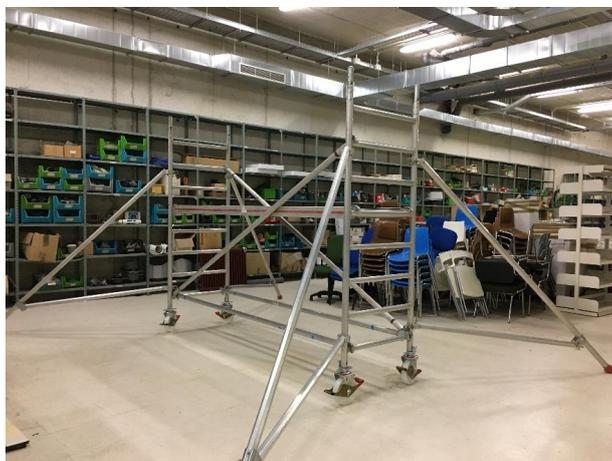
Acceder a la plataforma, **recordar siempre** por la zona interior y colocar los dos marcos con sus cierres de seguridad.
