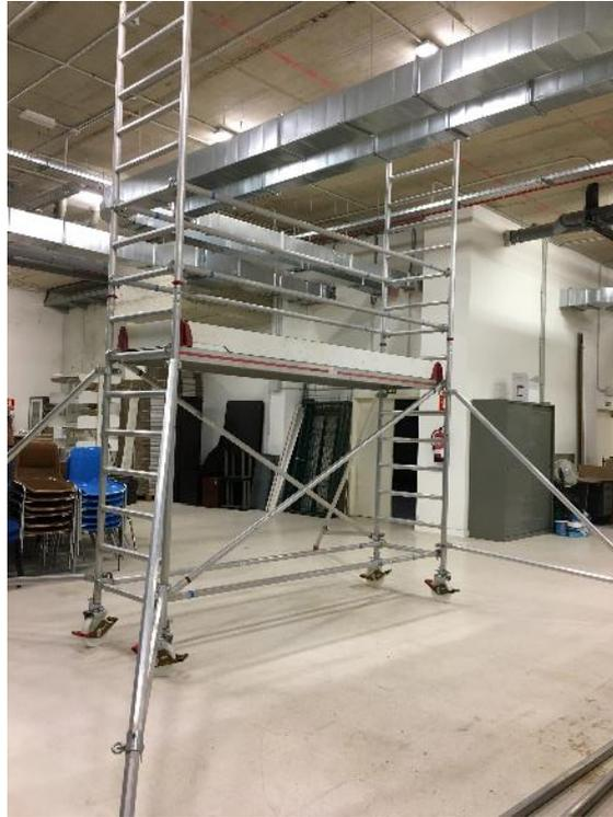
Colocar las ruedas, **ajustando el tornillo** al orificio existente para evitar la caída de las mismas, **frenar las ruedas** para continuar con el montaje.
